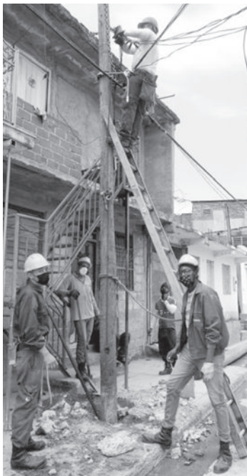
ETECSA resuelve poste dañado en Calle 6 de Zamorana
