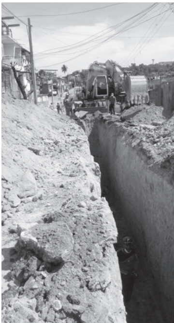
Sustitución de la tubería maestra del alcantarillado en Calle B y 3ra, reparto Vista Hermosa. Apoyando a Aguas Santiago una brigada de Granma
