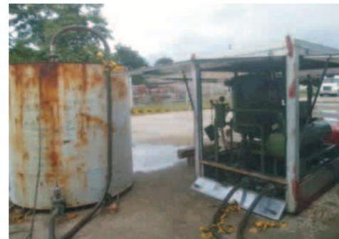
WhatsApp imágenes de la descarga de la máquina recirculadora para el tratamiento del aceite dieléctrico, que es clave para solucionar el problema del transformador en Dos Caminos, San Luis.
