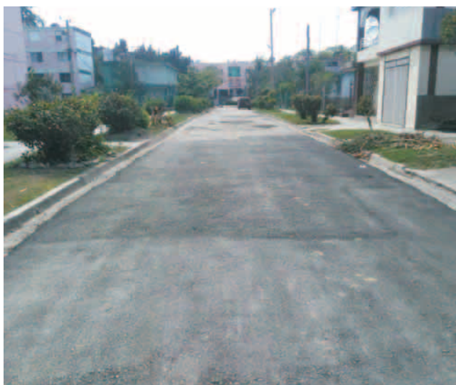
En Pastorita se trabaja en el mejoramiento de las calles
