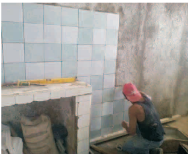
Reparación de Carnicería en El Caney
