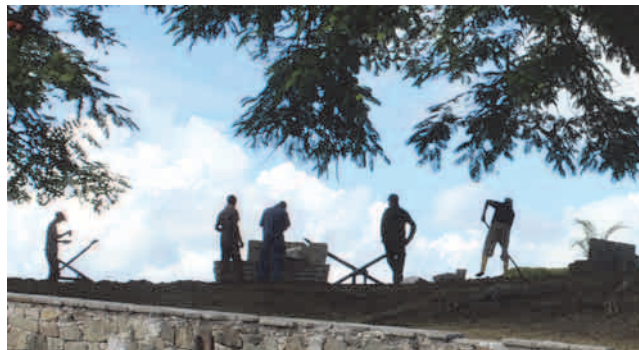
Trabajos de rehabilitación del parque comunitario
