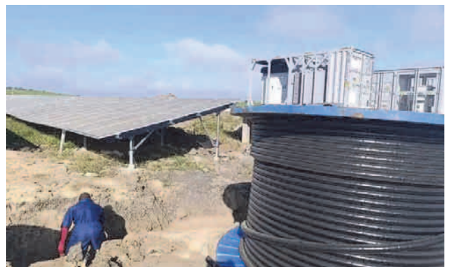
Trabajos en el Parque solar fotovoltaico Rafael Reyes, en San Luis
