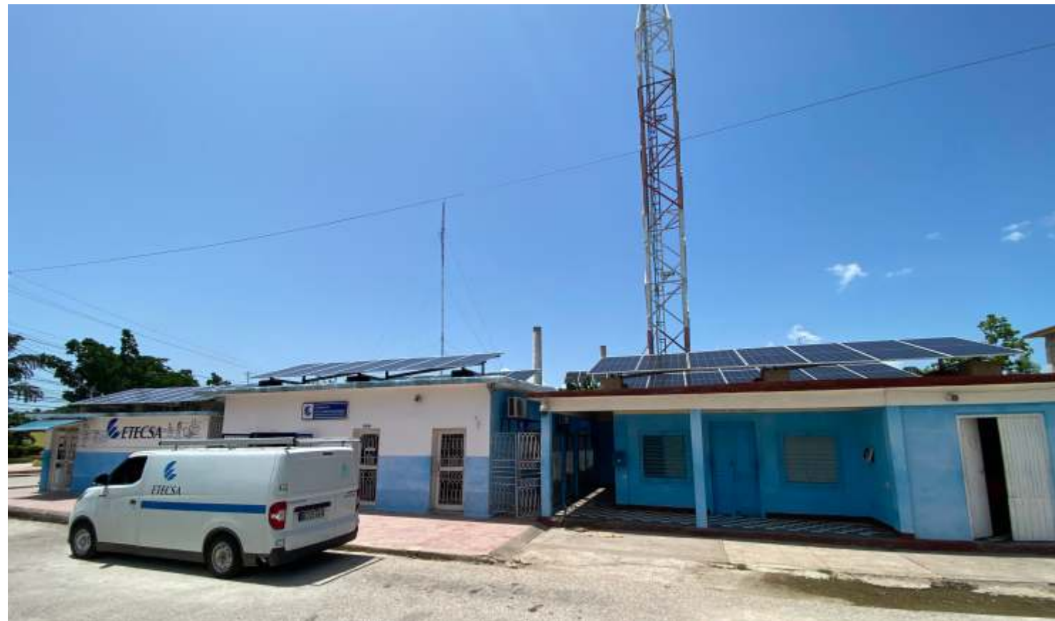
En comunidades rurales se ha procedido a la instalación de paneles solares fotovoltaicos en los sitios tecnológicos de Etecsa Fotos: Dirección Territorial de Etecsa
