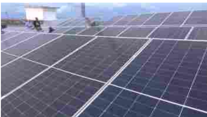
En el Centro de Telecomunicaciones de Tercer Frente avanza la instalación de los paneles solares
