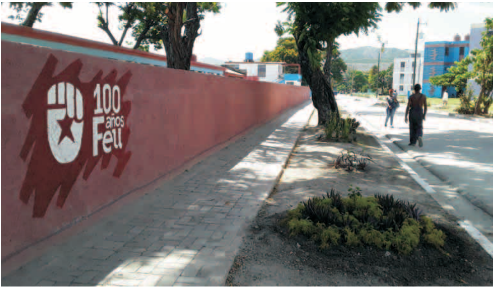
Muro perimetral de la secundaria Manuel Asuncue Domenech
