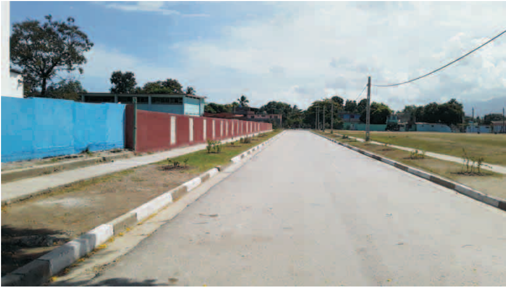
Se rehabilitaron calles y aceras
