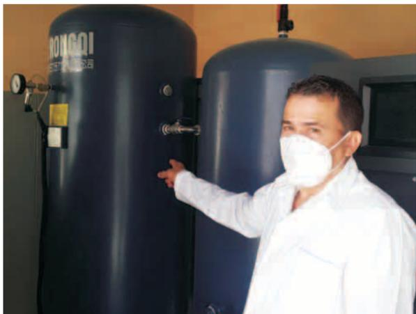
instalación, esta tecnología utiliza el aire del medio ambiente como materia prima, separando el oxígeno del nitrógeno por el principio de absorción a alta presión y no emite contaminación acústica que afecte el funcionamiento de la institución hospitalaria.
